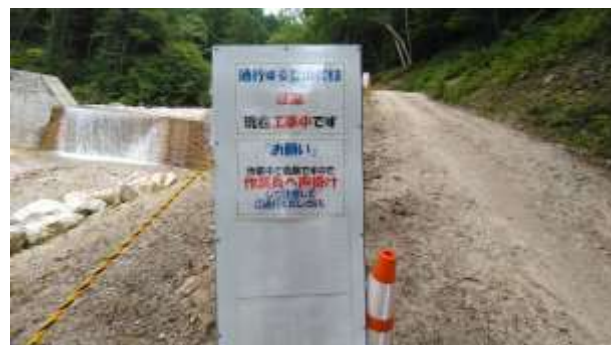
砂防ダム工事現場。作業員への声掛けが求められている。
